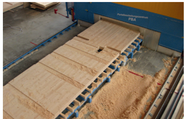
Bis zu 16 m lange Bauteile können bei Biber Holzbearbeitung mit der PBA bearbeitet werden
